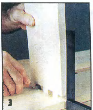
Совместите лицевые кромки перегородки и дна. Обозначьте границы гнезд.
