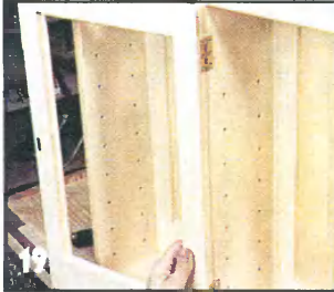
Выберите гнезда и прикрепите петли к дверце, затем разметьте гнезда на перегородке.
